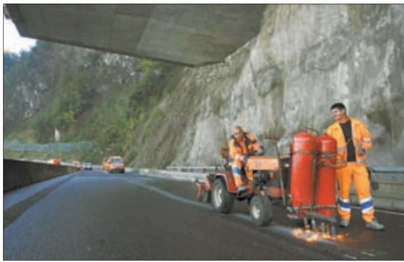
Letzte Arbeiten an der sanierten Strasse.
